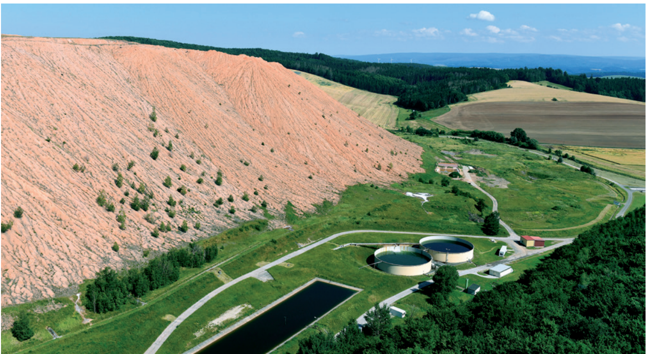
Standort Bischofferode mit Laugenstapeleinrichtungen. Quelle: LMBV, Peter Radke, 2020.
