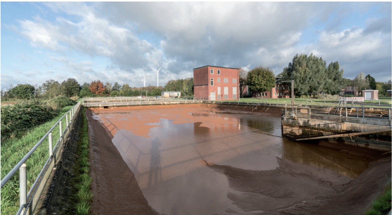
Mit Filterschlamm gefülltes Absatzbecken. Quelle: Hamburg Wasser.
